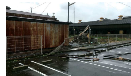
▲駐車場のフェンスも強風の被害に(当日の様子)
